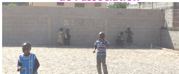
Aménagement du jardin d'enfants à Goudomp Construction du mur de clôture
